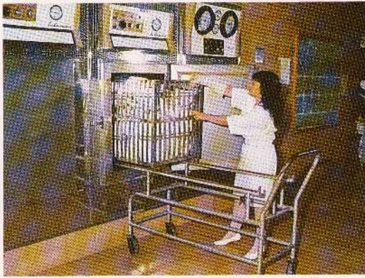
Central de óxido de etileno
